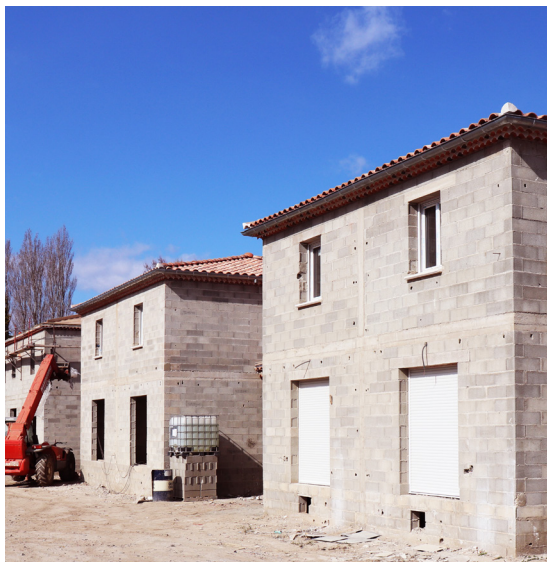
Maisons groupées en construction à Jonquières-Saint-Vincent en 2018.
