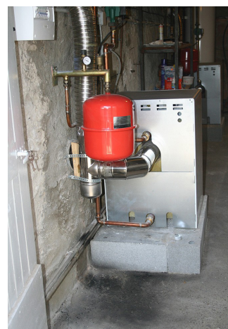
3) Rehaussement d'une chaudière
