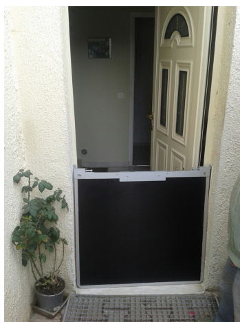
1) installation de batardeau dans une maison de ville
