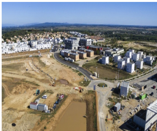
La ZAC des Ferrières en cours de réalisation
