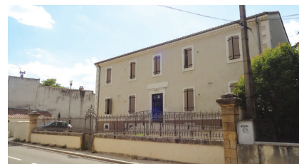
Ancienne gendarmerie transformée en logements sociaux à Saint-Chaptes.
