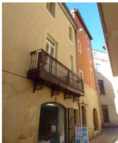
Immeubles réhabilités dans la rue Sainte-Eugénie
